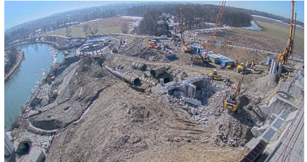
Baubereich Kraftwerk Töging
