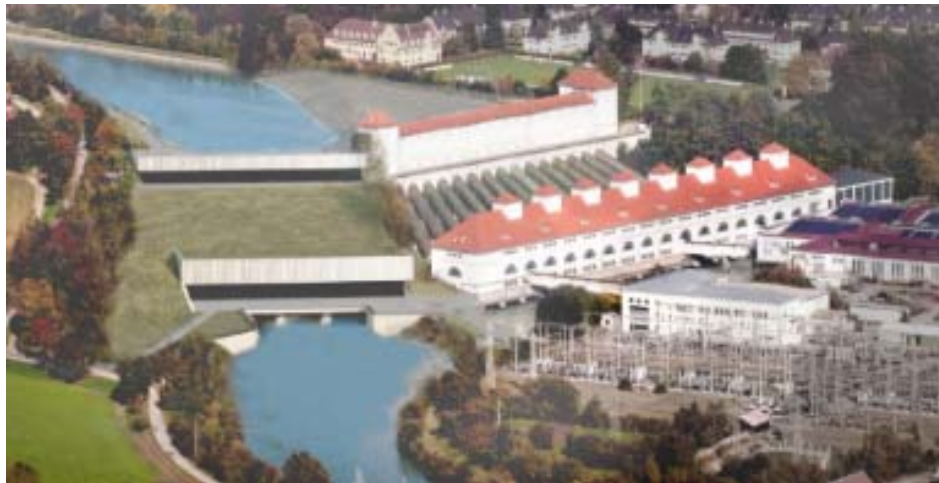
Erneuerung und Erweiterung KW Töging (557 GWh + 139 GWh)
