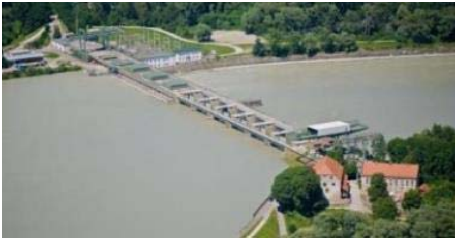
Weiterbetrieb und Effizienzsteigerung des KW Erling-Frauenstein und ... (434 GWh +50 GWh*)
