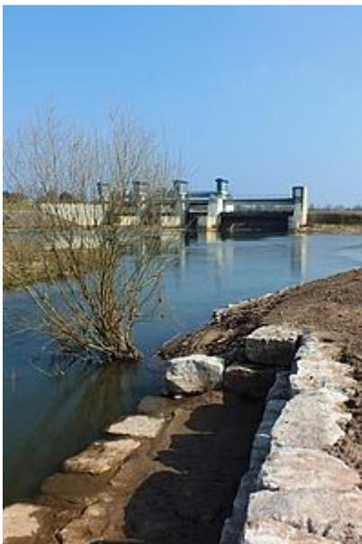
Energieerzeugung kann durchaus ökonomische UND ökologische Aspekte sinnvoll verbinden. Ein Beispiel hierfür ist die „Wasserkraftschnecke Neuses“. Dabei handelt es sich um ein hochmodernes und fischverträgliches Wasserkraftwerk, das im April 2015 in Betrieb genommen wurde. Der Bau des Kraftwerks hat 1,4 Millionen Euro gekostet.
