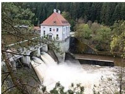
Die Kraftwerk am Höllenstein AG, ein Unternehmen der Stadtwerke Straubing GmbH, betreibt mit dem Kraftwerk am Höllenstein und dem Ausgleichswerk Pulling zwei Wasserkraftwerke am Schwarzen Regen. Die beiden Kraftwerke erzeugen rund 20 Millionen Kilowattstunden Strom im Jahr. Das entspricht etwa 7 Prozent des Bedarfs der Stadt Straubing. Bisher stellten die Kraftwerke eine
