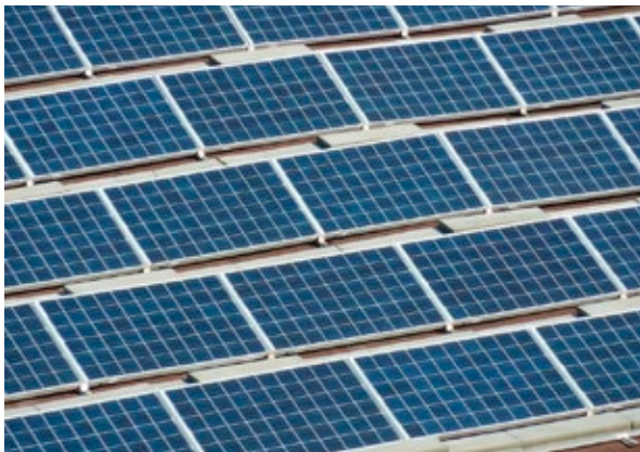
Abb. 2-5: Solarzellen aus polykristallinem Reinstsilizium
