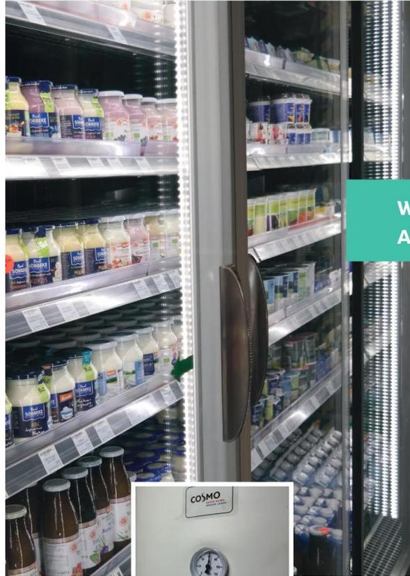
Die alten Leuchtmittel auf Basis von Metall- und Quecksilberdampf („Leuchtstoffröhren“) wurden auf LED umgerüstet. Dabei konnte nicht nur Energie gespart, sondern zusätzlich auch die Lichtleistung erhöht werden.
